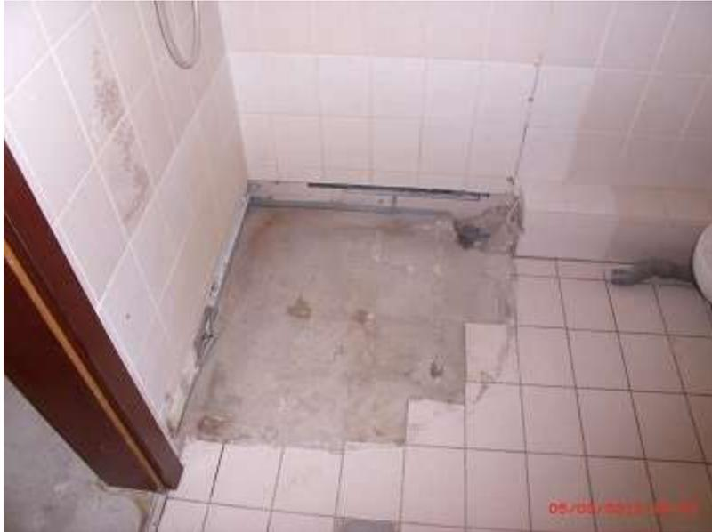
Die Ursache für die hohe Feuchtigkeit war eine angerissene Silikonfuge an der Duschtasse im Wandanschluss. Das Duschwasser führte im Estrich- und Wandaufbau zur Schimmelpilzbildung. Die Raumluft war dauerhaft, vermutlich über einen längeren Zeitraum, mit Schimmelpilzsporen kontaminiert.
