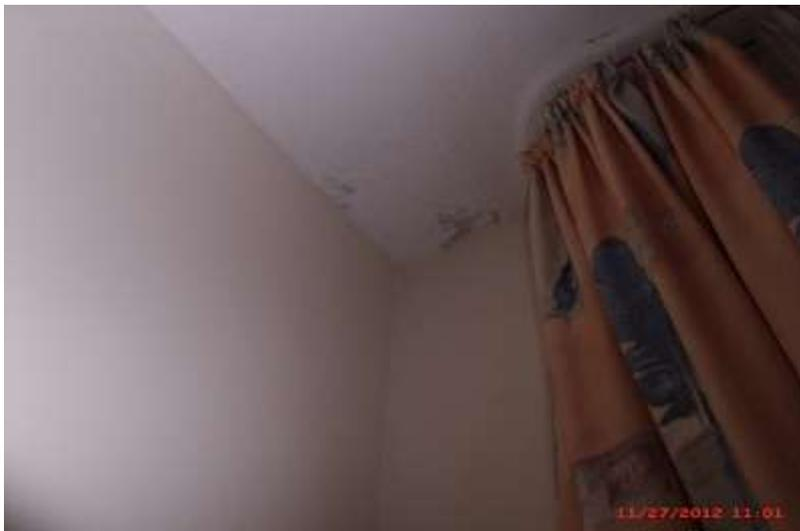
Farbliche Veränderungen in der Außenwanddecke und unter der Geschosdecke zeigen eine typische Wärmebrücke.
