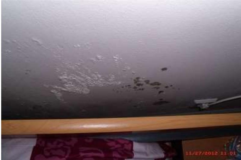
Schimmelpilzbildung hinter der Bettanlage. Hohe Feuchtigkeitseinträge und verminderte Konvektion, sowie zu kühle Raumlufttemperaturen lassen Schimmelpilze wachsen.
