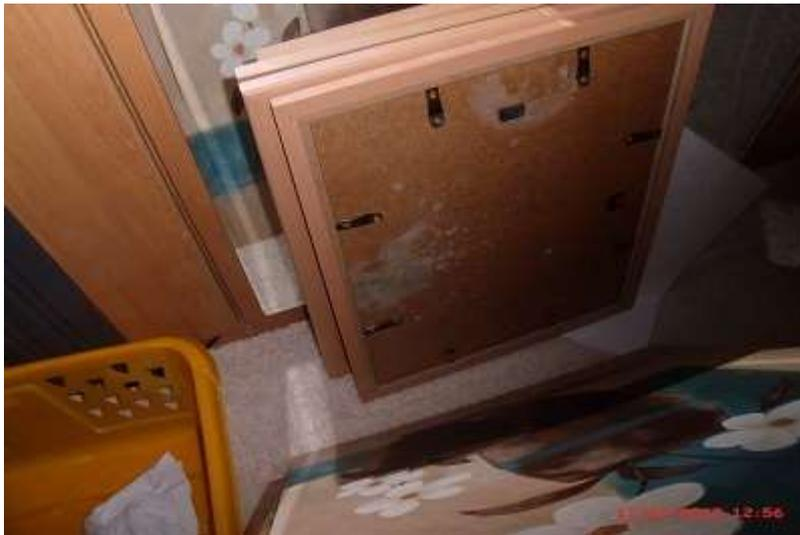
Die Bilderrücken, der an der Außenwand hängenden Bilder, sind durch verminderte Konvektion und zu geringer Wandoberflächentemperaturen verschimmelt
