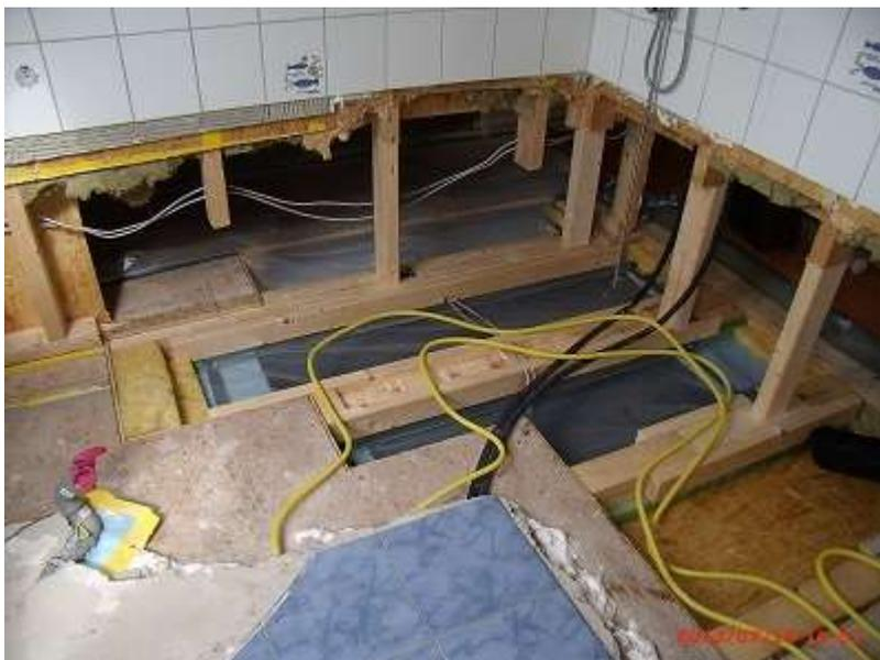
Die Handwerker der Versicherung haben den Rückbau der von Schimmelpilz befallenen Materialien durchgeführt. Im Anschluss wurde die abgeschottete Räumlichkeit von der Sanierungsfirma gereinigt.
